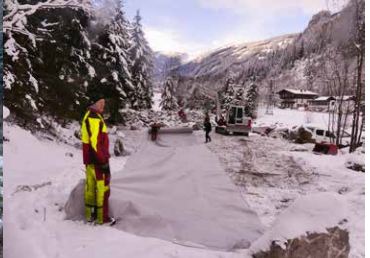
Folien werden ausgelegt
