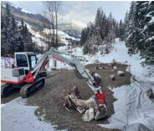
Der Teichboden wird befestigt
